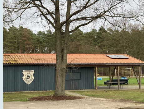
Frisch installiertes Balkonkraftwerk auf dem Sportgelände.
